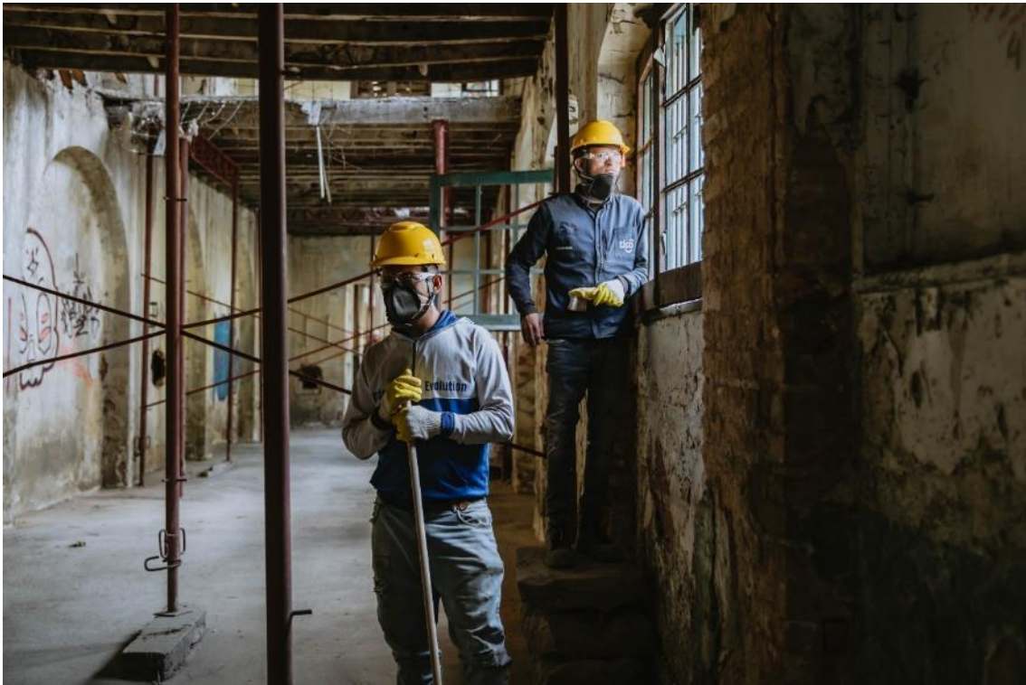
Foto. Obras de reforzamiento y adecuación / Bronx Distrito Creativo – FUGA.
