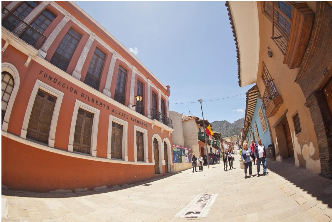
Foto. Sede Principal FUGA / Calle 10 – FUGA.
