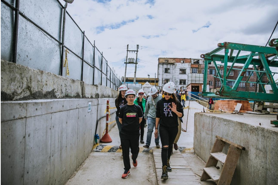
Foto. Visita Alcaldesa Mayor Obras BDC – FUGA.
