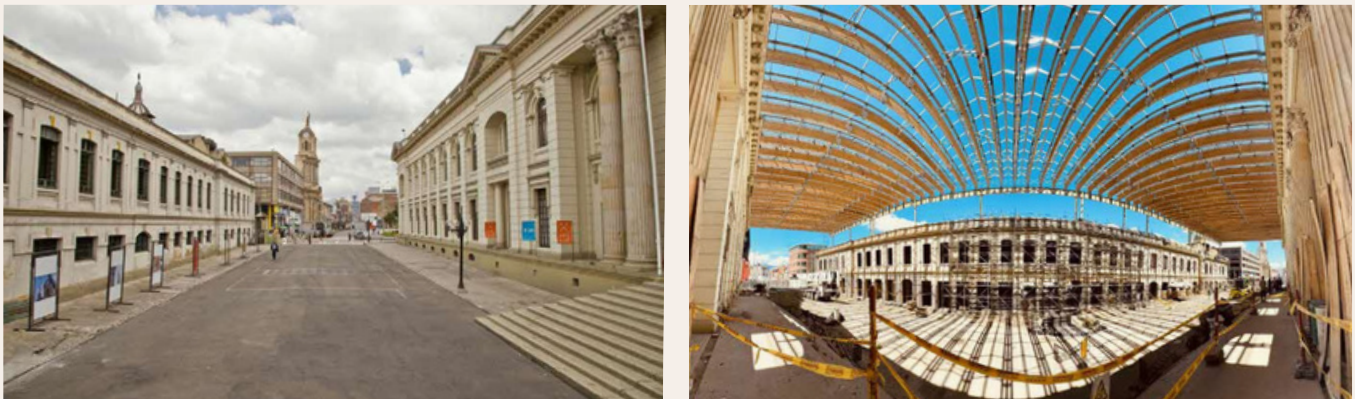
La Milla antes de la construcción (izquierda). El techo que cubrirá la calle peatonal fue finalizado en 2024 (derecha).
